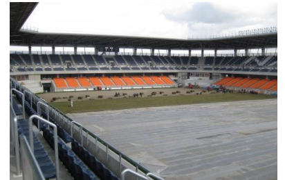
工事中ピッチ全景（長野市ホームページより）
