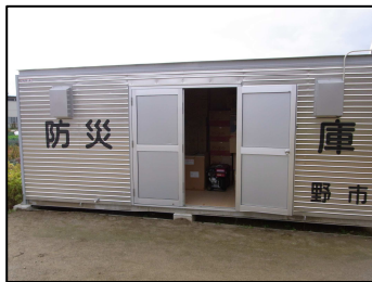
水鉋公園にある備蓄倉庫
